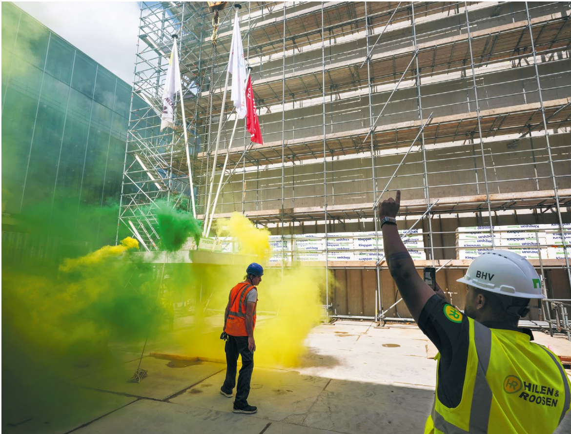
Pannebier voor het Liesbeth List Huis op Oostenburg. Dit wordt een plek voor kunstenaars en kunstliefhebbers met een zorgindicatie. Door symbolisch de laatste plaat beton naar boven te hijsen werd eind mei het hoogste punt van de bouw gevierd. Eind dit jaar wordt de oplevering verwacht.
