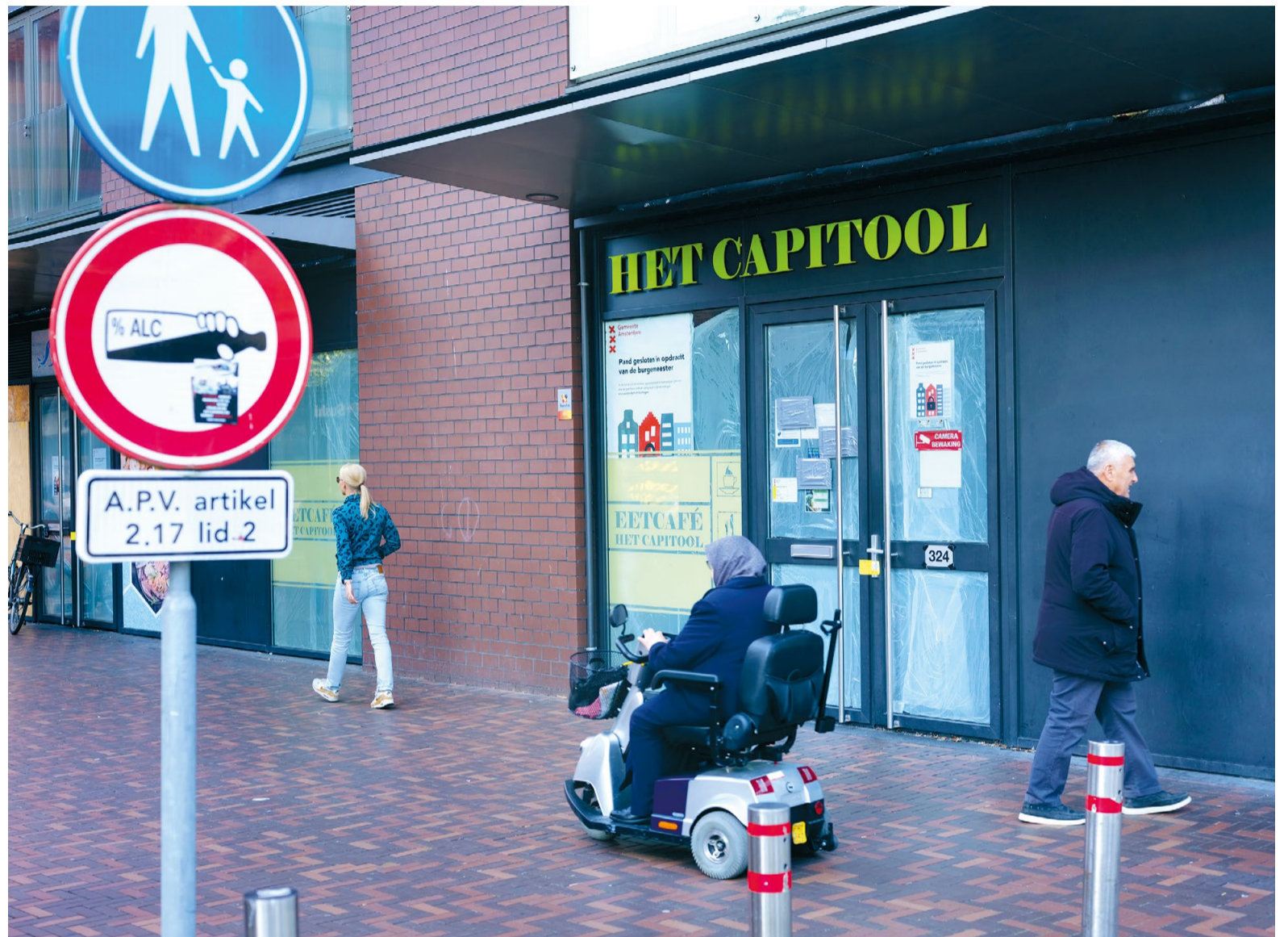
Vanwege explosies en kogelgaten dichtgetimmerde winkelpanden bij Winkelcentrum Waterlandplein.
