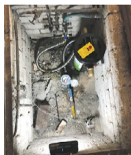
Filter geplaatst in kruipruimte
