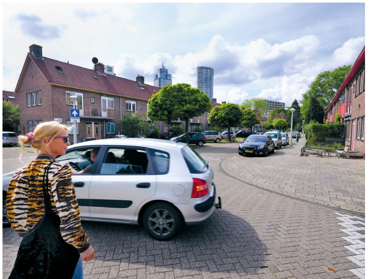
Amsteldorp ligt bij het Amstelstation en bestaat voor 100 procent uit sociale woningbouw in bezit van Ymere. Ruwweg driekwart van de 490 woningen wil Ymere renoveren. De rest (113 woningen) wordt gesloopt, daar komen 213 woningen voor terug.
