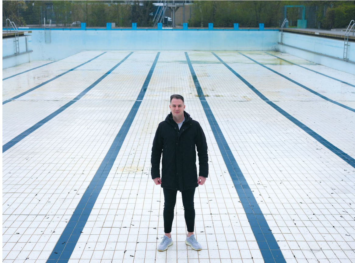
Locatiecoördinator Ramon van der Terp in het Flevoparkbad. Aan het onderhoud van de vloer wordt nu de laatste hand gelegd, op 28 april gaat het buitenbad van Oost weer open.
