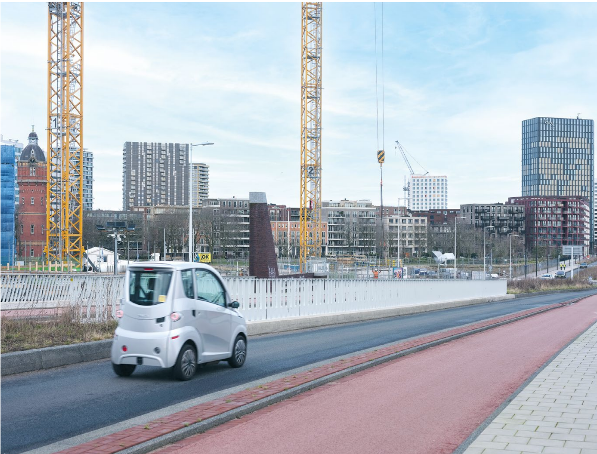
Het gebied rond de Spaklerweg in het Amstelkwartier. Voor er gebouwd kan worden, moet eerst vervuilde grond worden afgegraven.
