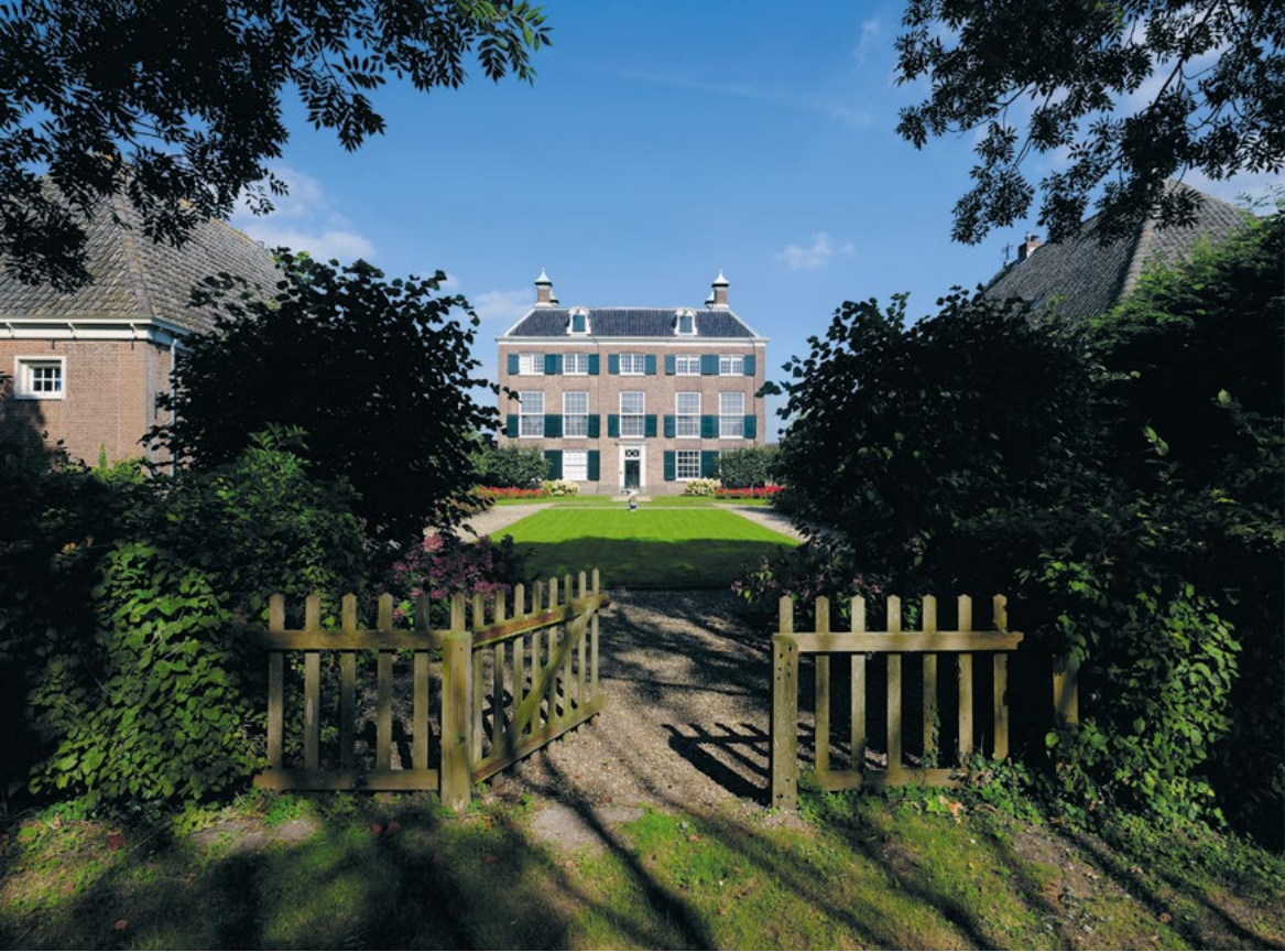
Sinds 1609 vergaderde het Hoogheemraadschap van Zeeburg en Diemerdiijk in die oude herberg. Toen het pand te bouwvallig werd, is de herberg gesloopt en is er een nieuw pand neergezet naar het ontwerp van de Amsterdamse timmerman Cornelis van der Does.
