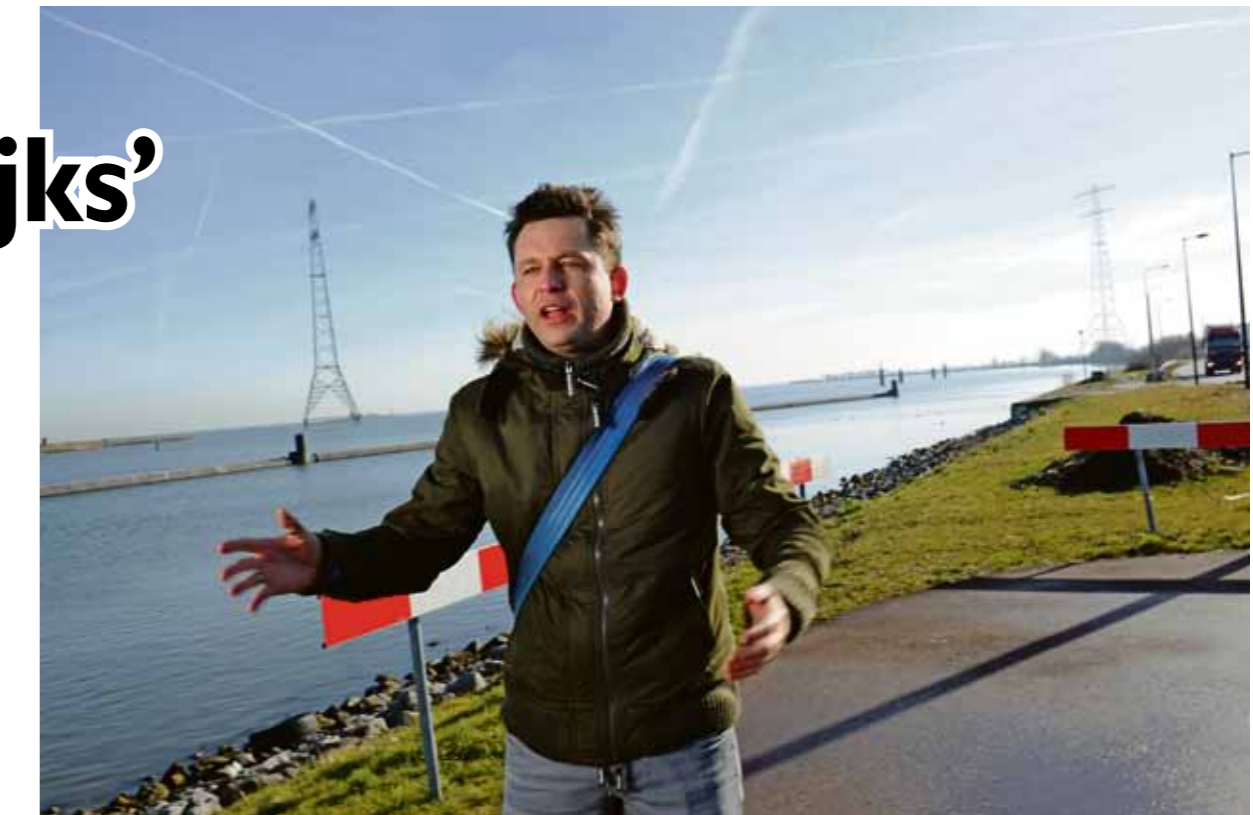
Marco van Vemden op de wandel- en fietsboulevard langs het Buiten-IJ, die ook dienstdoet als waterkering. FOTO MARTIJN VAN DEN DOBBELSTEEN
