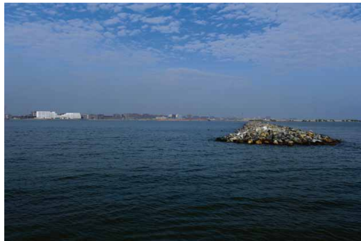
Nieuwe golfbreker voor de kust van het aanstaande Centrumeiland. FOTO MARTIJN VAN DEN DOBBELSTEEN
