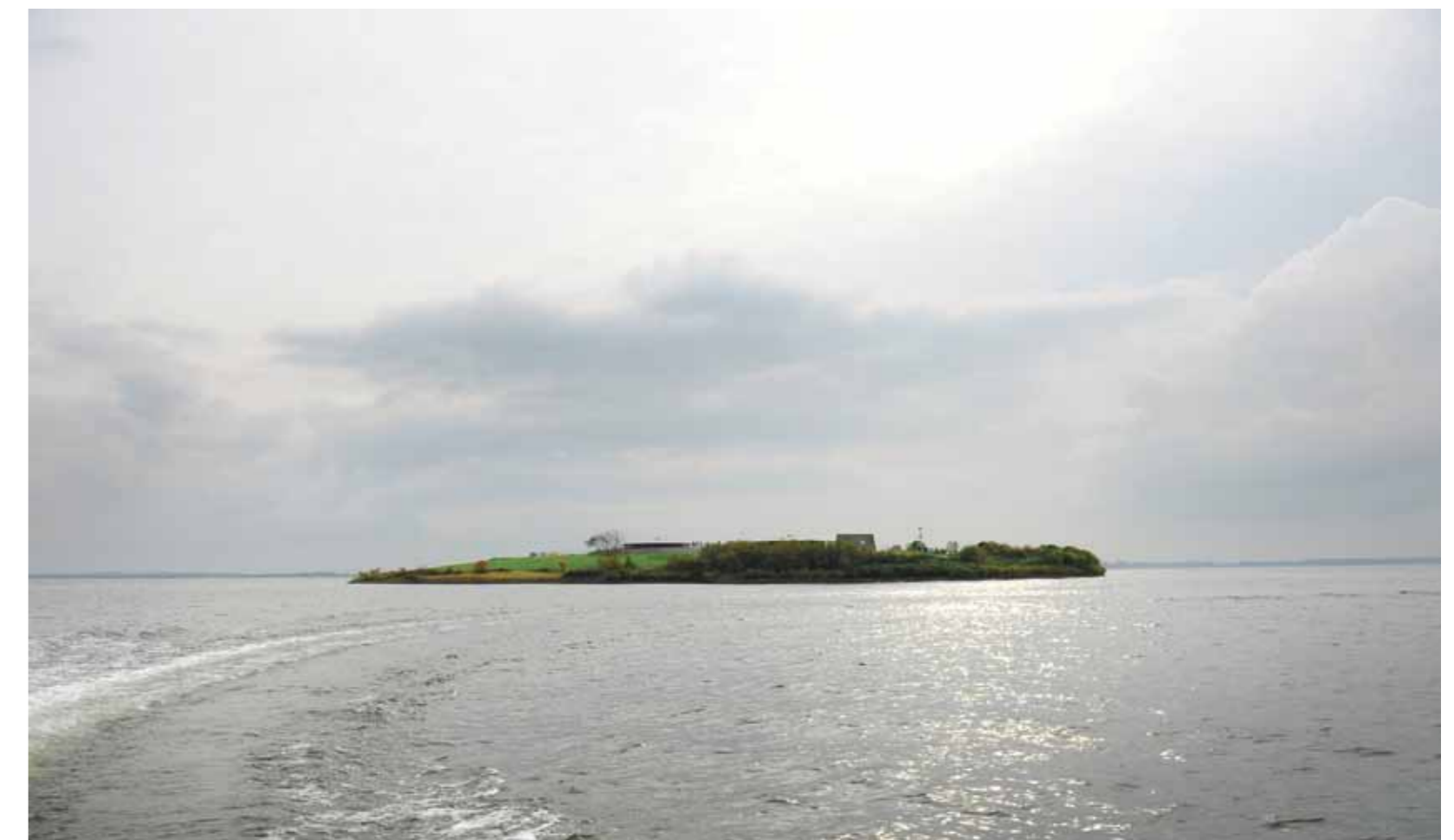
Fort Pampus werd tussen 1887 en 1895 gebouwd, op vierduizend heipalen van elf meter lang. FOTO MARTIJN VAN DEN DOBBELSTEEN
