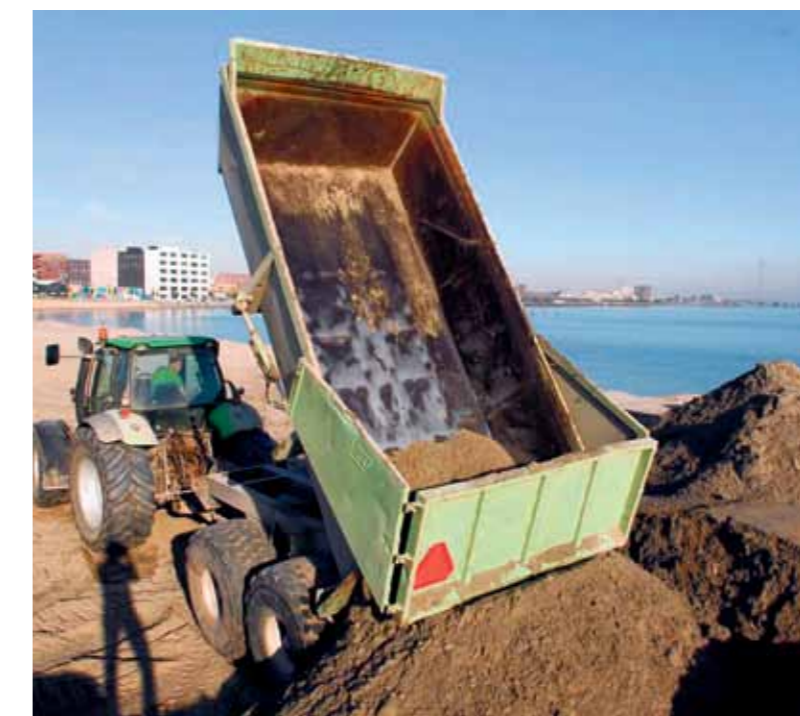
Binnenkort start het landmaken voor Centrumeiland, het eerste en voorlopig enige eiland van IJburg 2. FOTO MARTIJN VAN DEN DOBBELSTEEN
