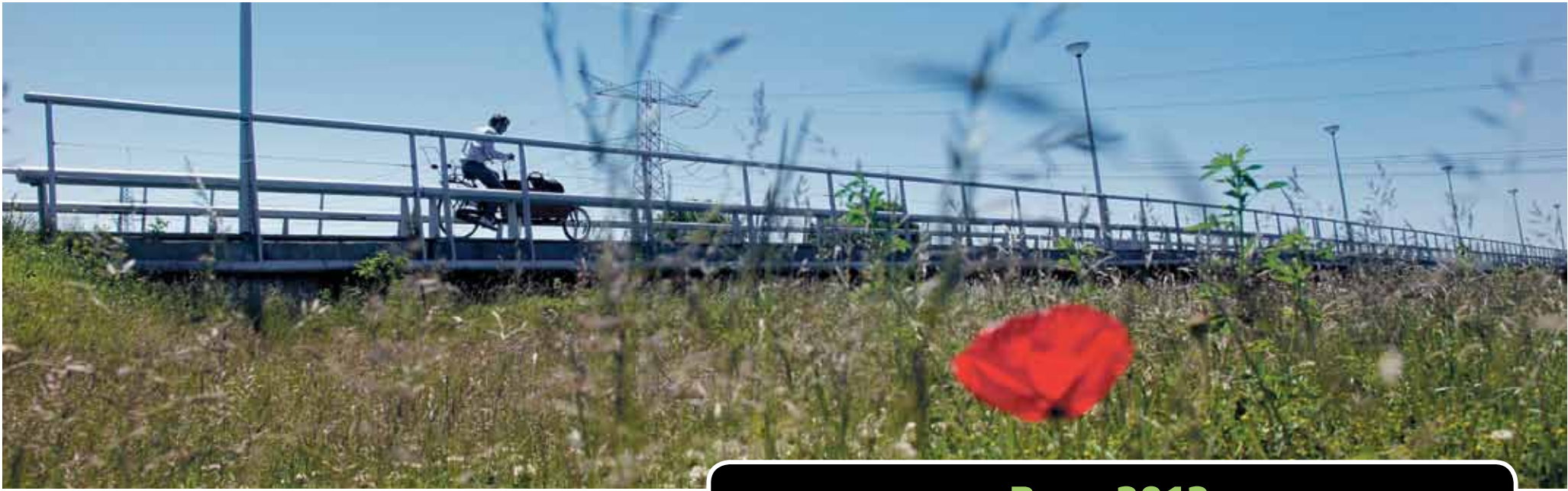
Waar Rieteland West • Verbindt Oeverzeggestraat met Dick Hilleniuspad en het Diemerpark • Over IJmeer • Bouwjaar 2001 • Doorvaarthoogte 2 meter • Doorvaartbreedte 10 meter • Ontwerp Benthem Crouwel Architecten
