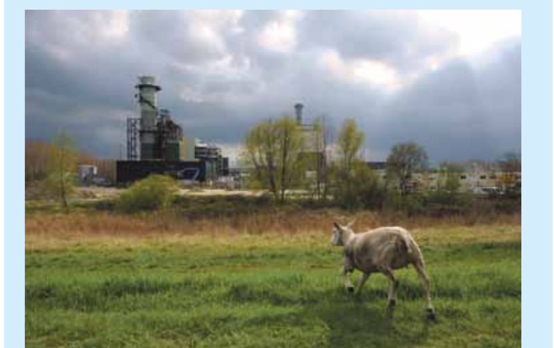
De centrale van Nuon, bij de Diemerzeedijk.
