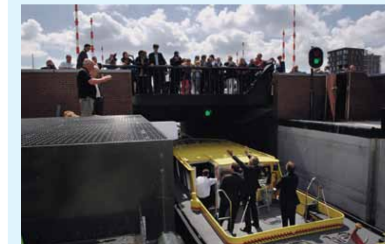
De feestelijke opening van de sluis in 2009. FOTO MARTIJN VAN DEN DOBBELSTEEN
