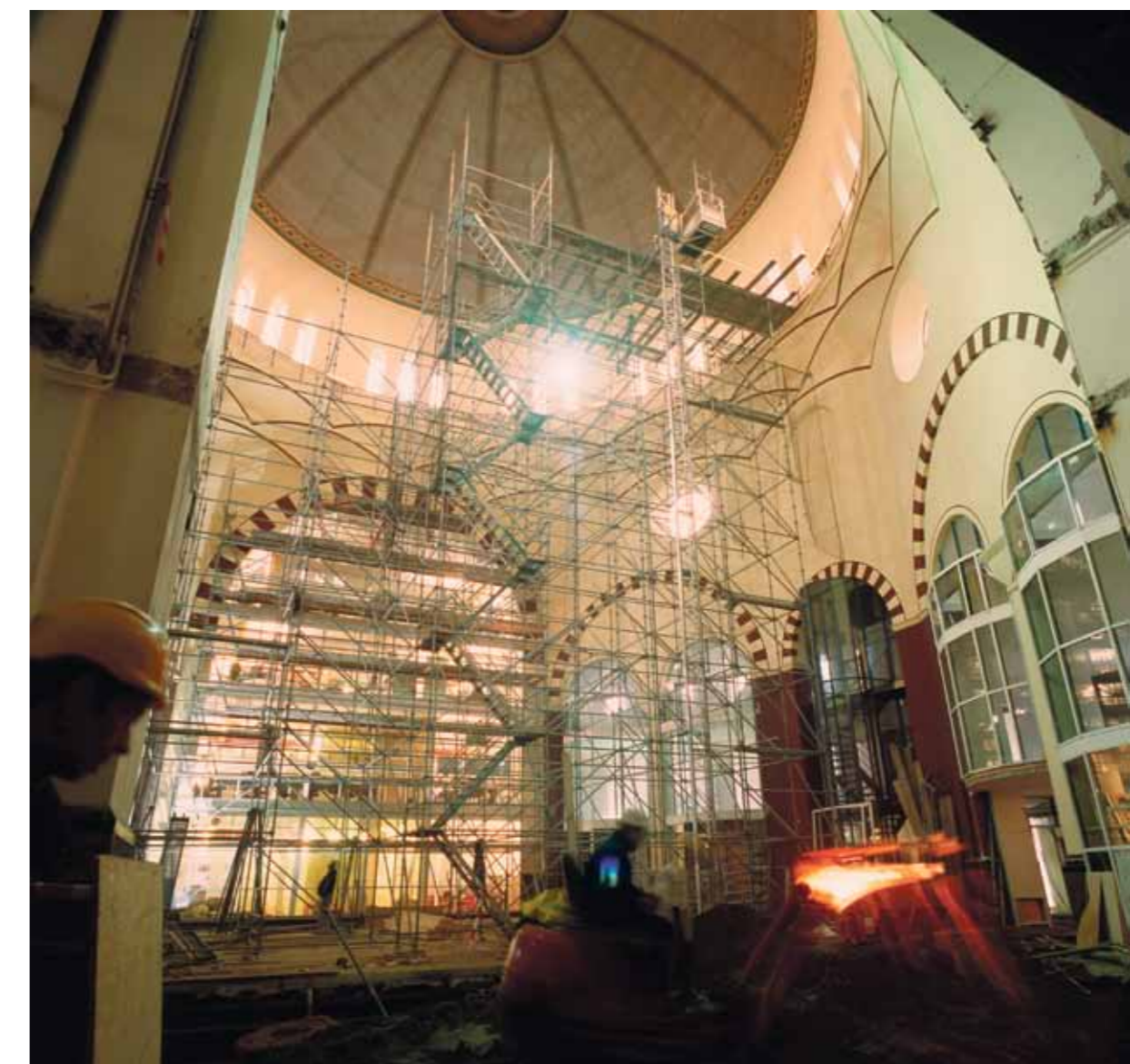
De Majellakerk in de Indische buurt wordt verbouwd. Twee toonaangevende orkesten maken er hun repetitieruimte van.
