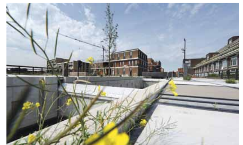
De nieuwe sluis aan het oosteinde van de Groene Tunnel. FOTO MARTIJN VAN DEN DOBBELSTEEN
