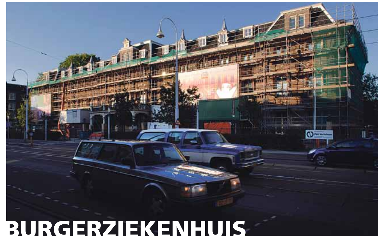
Architect Kentie en Partners Bouwjaar 1891
