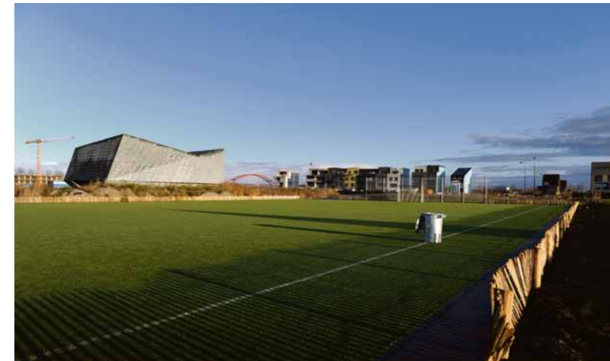
Het boostergemaal op Zeeburgereiland zorgt ervoor dat het rioolwater uit Oost naar de waterzuivering (Westelijk Havengebied) wordt gepompt. FOTO MARTIJN VAN DEN DOBBELSTEEN
